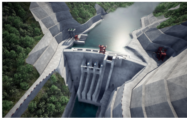
Pembangkit Listrik Tenaga Air (PLTA)
